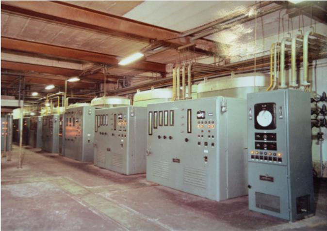
**Bild 1:** Fünf Endogas-Generatoren mit einer Nennleistung von jeweils 180 Nm<sup>3</sup>/h. Vorne rechts Taupunkt-Regelausrüstung Baujahr 1961
