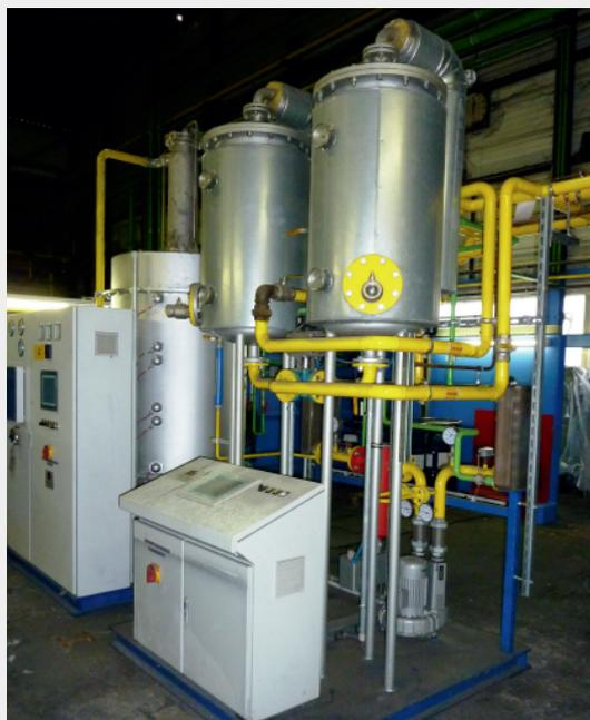
**Bild 10:** Adsorptionsanlage mit Molekularsieb zur Reinigung von 60  $\text{Nm}^3/\text{h}$  Endogas
